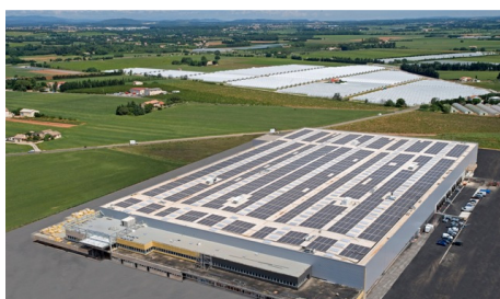
La Poste, Montpellier, France, 700 kWp
